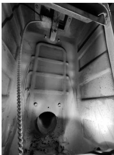
Fig. 33 - Wyczyścić szczotką do rur
