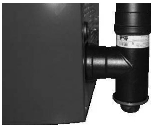
Fig. 28 - Czyszczenie czopucha
