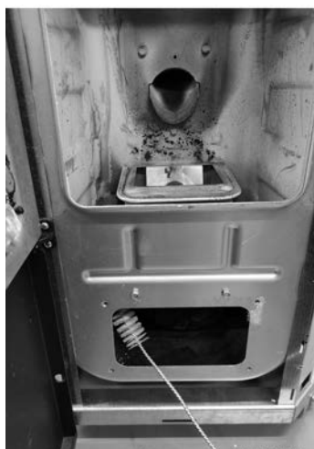
Fig. 31 - Wyczyścić szczotką do rur
